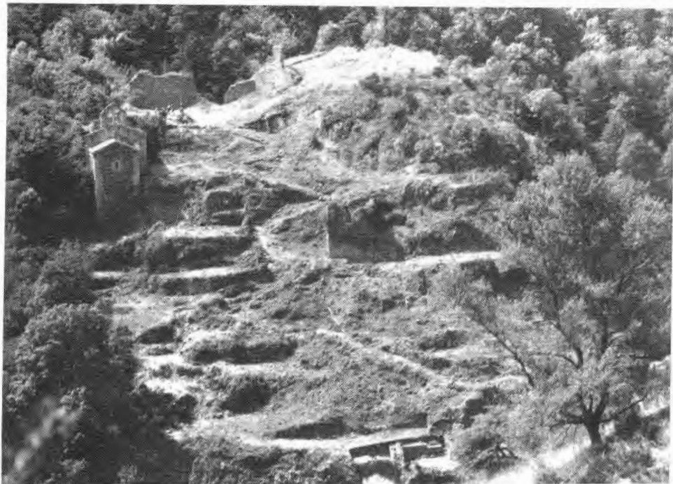
Fig. 16. L'aménagement du site en terrasse de culture photographié en 1980 après le déboisement et débroussaillage complet de la zone occupée à l'époque médiévale. En bas au centre, la "porte de la barrière" en cours d'exploration.
