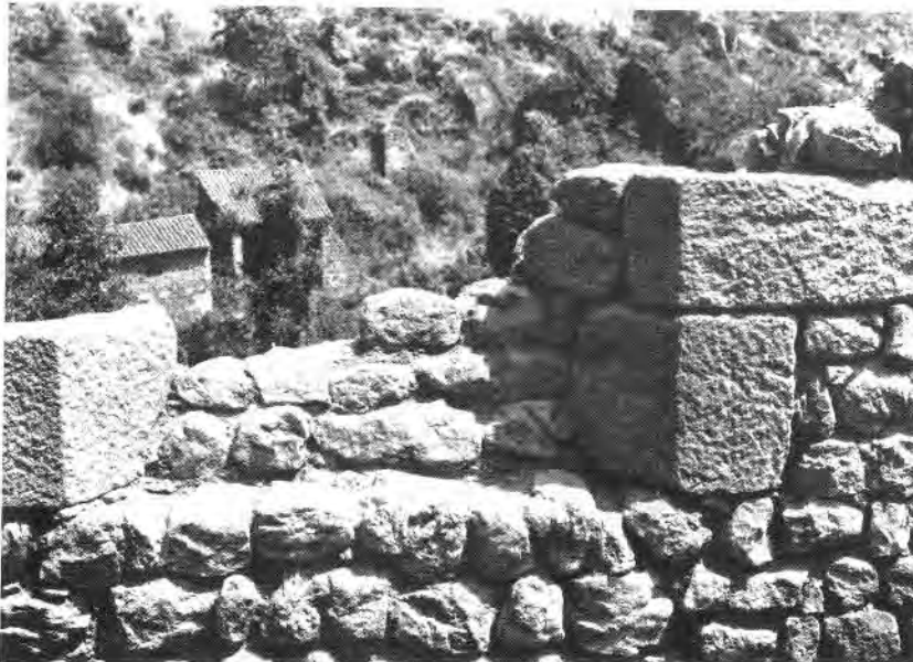
Fig. 3. L'archère de la "porte de la barrière", vue de l'intérieur de l'édifice (mur est, secteur K 1, K 2, K 3).
