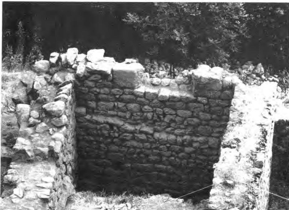
Fig. 7. Bâtiment VI. Le parement interne du mur est (687) avec l' "archère" et la semelle débordante.
