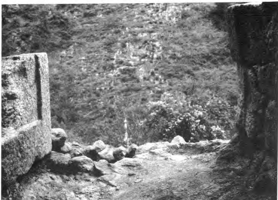
Fig. 12. Bâtiment IV. Les piédroits de la porte, vus de l'intérieur. Bloc mouluré à gauche. A droite, la feuillure indique une porte s'ouvrant vers l'intérieur. Les dimensions du trou qui apparaît dans la seconde pierre sont trop importantes pour correspondre à l'implantation d'un gond ; il s'agit plus vraisemblablement du logement d'un verrou.
